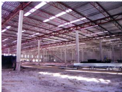
Intervento di protezione passiva dal fuoco con intaco isolante eseguito nel deposito centrale IKEA (PC)
