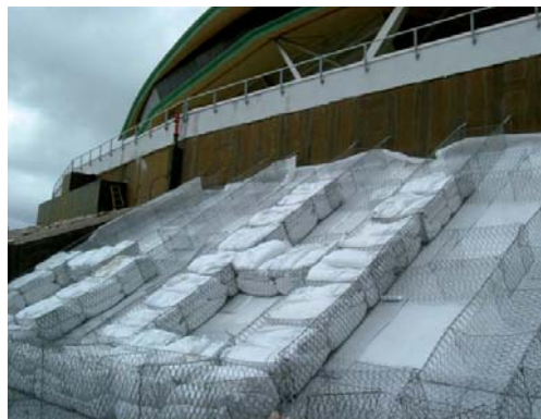
Posa di sacconi su copertura inclinata
