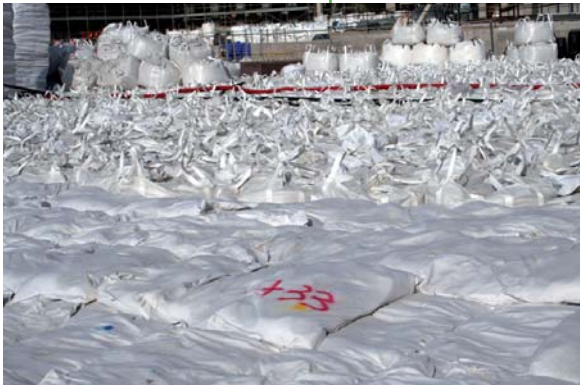
Stesura di sacchi e sacconi in multistrato per stratigrafie di spessore elevato e variabile
