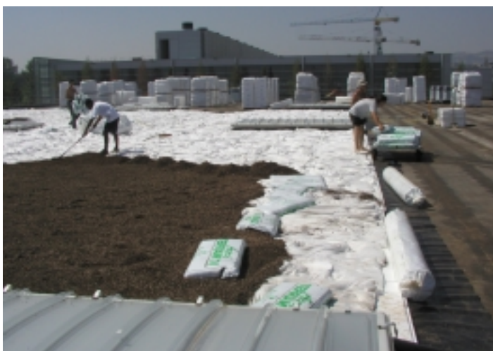
Copertura a verde estensivo su copertura in lamiera grecata, di peso molto contenuto e a bassa manutenzione
