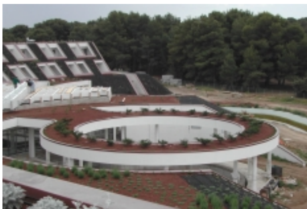
Copertura a verde intensiva su terrazza piana e su falde fortemente inclinate, nelle varie fasi di realizzazione
