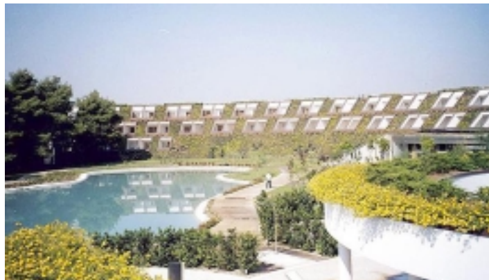
Copertura a verde intensiva su terrazza piana e su falde fortemente inclinate, nelle varie fasi di realizzazione
