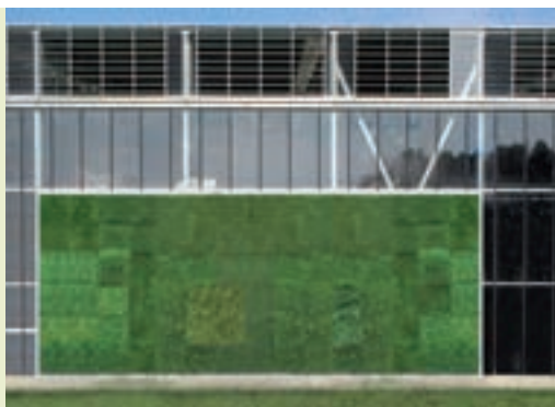
Realizzazione di parete verde: il rivestimento erboso ricopre solo una porzione della facciata e le essenze sono di più tipi distribuite lungo lo sviluppo del fronte (Foto Tecology).
